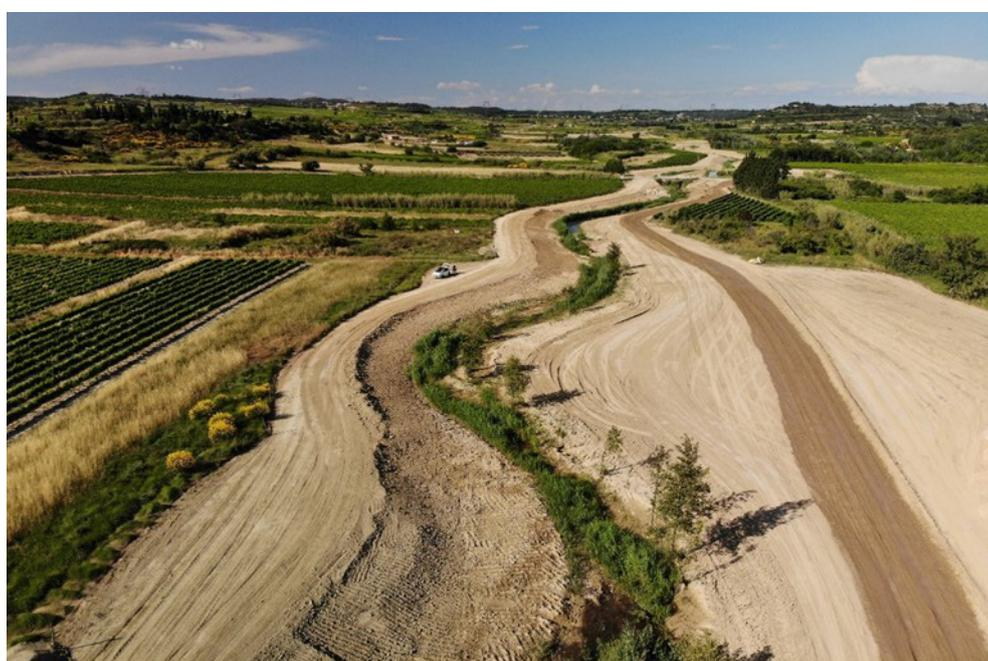
**>>> Reprise de la passe à poissons de Remoulins**, rendue nécessaire par l'enfoncement du Gardon en lien avec le contournement du seuil situé plus en aval (seuil de l'ancienne prise d'eau du canal de Beaucaire). Les travaux préparés en 2020 se déroulent en 2021.
